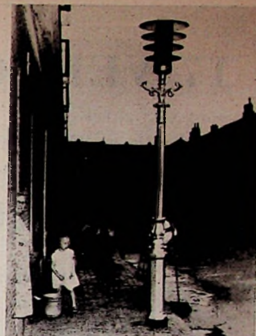
Een hypermodern pagode-armatuur met T.L.-buizen, gemonteerd op een gaslantaarnpaal van omstreeks 1880
