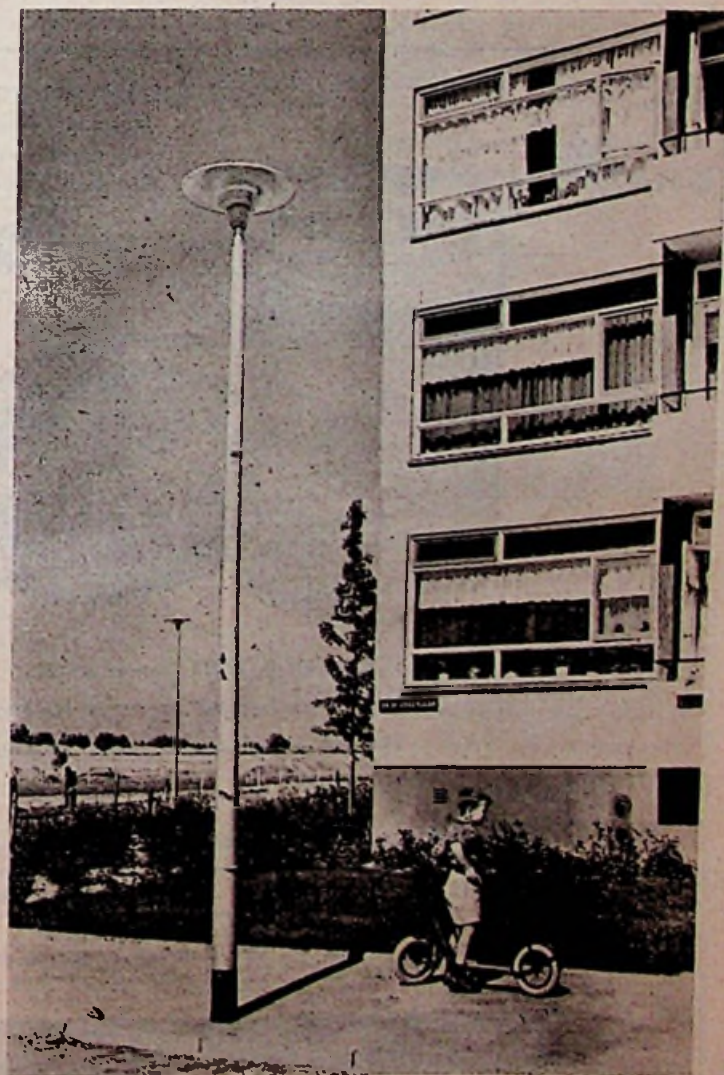
In de moderne wijken verschijnen hoogst moderne circle-line armaturen, voorzien van cirkelvormige fluorescentiebuizen.
