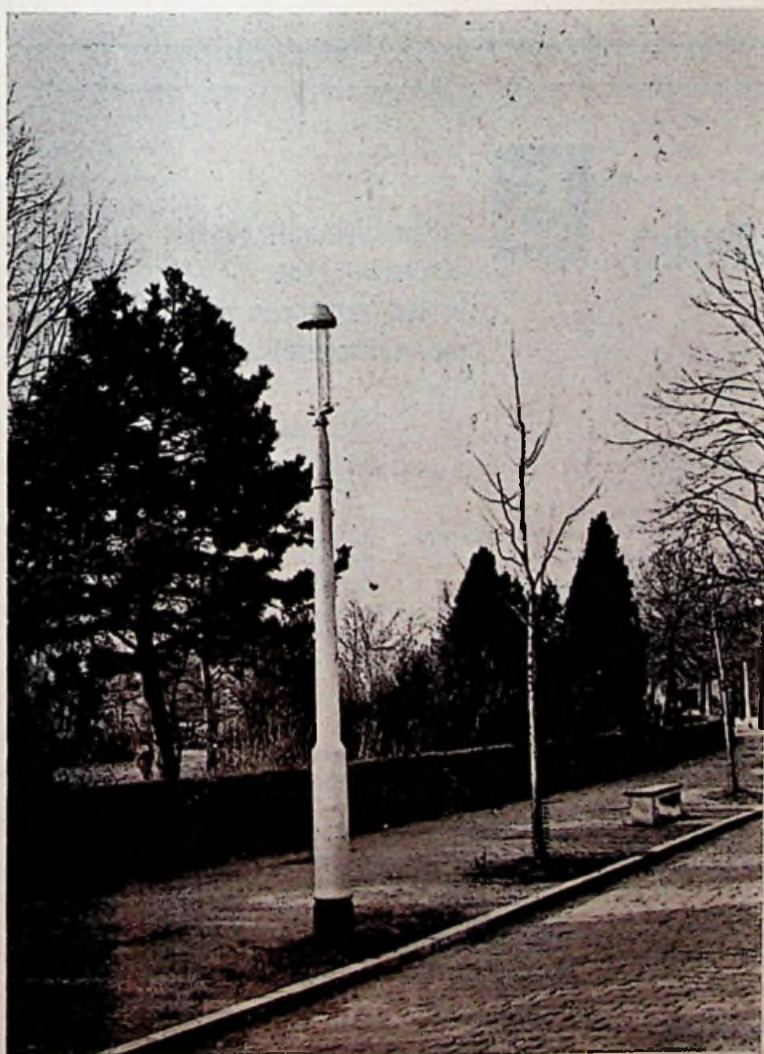
Dit zuilarmatuur met twee fluorescentiebuizen, hoe fraai men het ook kan vinden, voldoet uit verkeerstechnisch oogpunt minder goed en zal daarom weer verdwijnen
